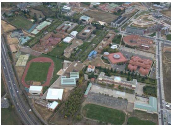
Vista aérea del Campus universitario
